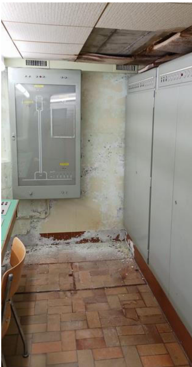
Dans la salle de commande...
