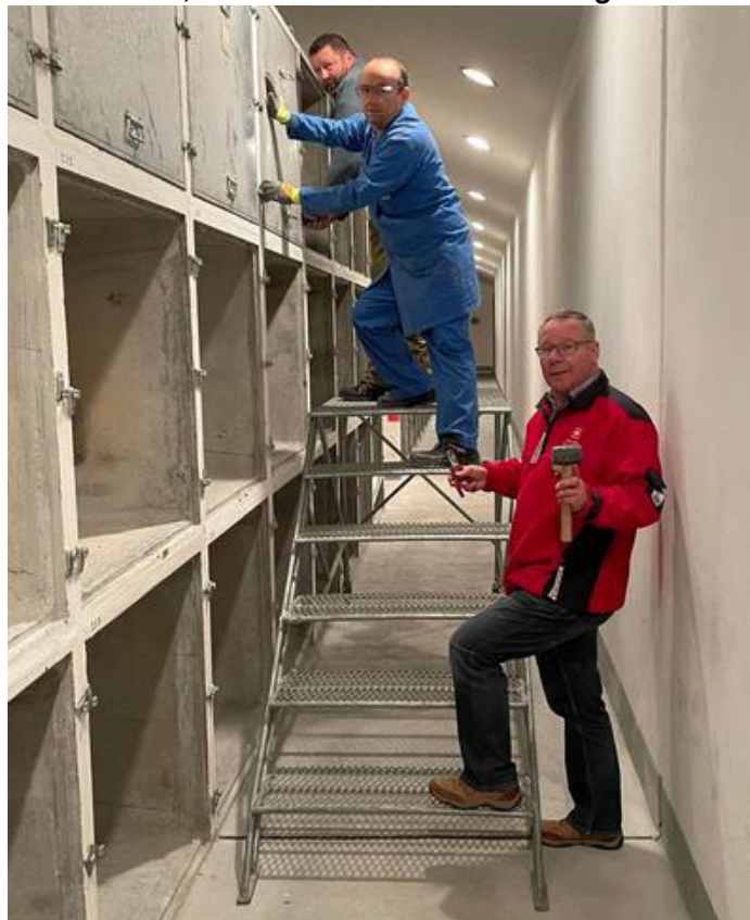
Magasin des charges, début de la remise en état
