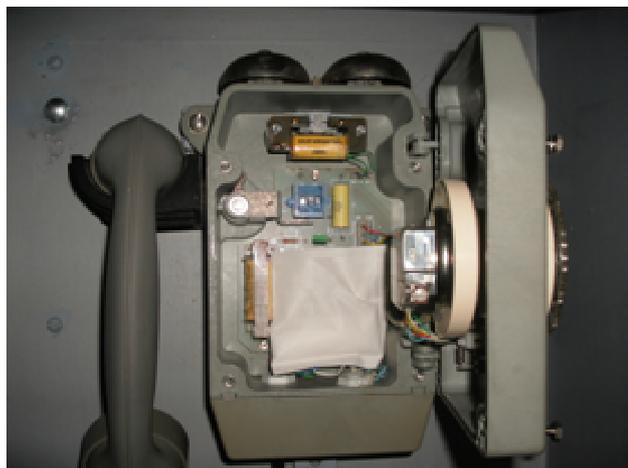
Photo de gauche : l'ancienne situation. Ci-dessus : un sachet de silicagel a été introduit dans le nouvel appareil placé lui-même dans le coffret qui a reçu 4 couches de nouvelles peinture à l'extérieur, photo ci-dessous.
