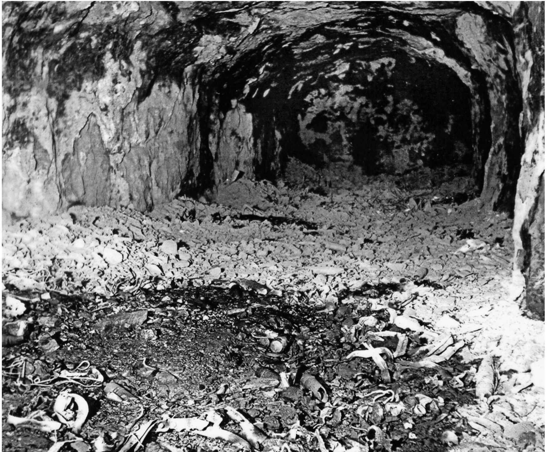
Ce qui resta du magasin de munitions No 1, point zéro de l'explosion de 1946. Il contenait 5500 obus. PHOTOS FONDATION FORTERESSE HISTORIQUE DE SAINT-MAURICE
